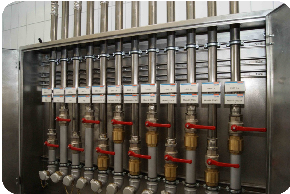
卸油站 - 用于新油从原包装注入储油桶
